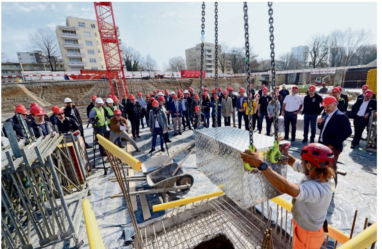
Mithilfe eines Krans wird die Grundstein-Kiste in die Lücke im künftigen Wincity-Parkhausboden eingelassen, anschliessend wird zubetoniert. Marc Dahinden
