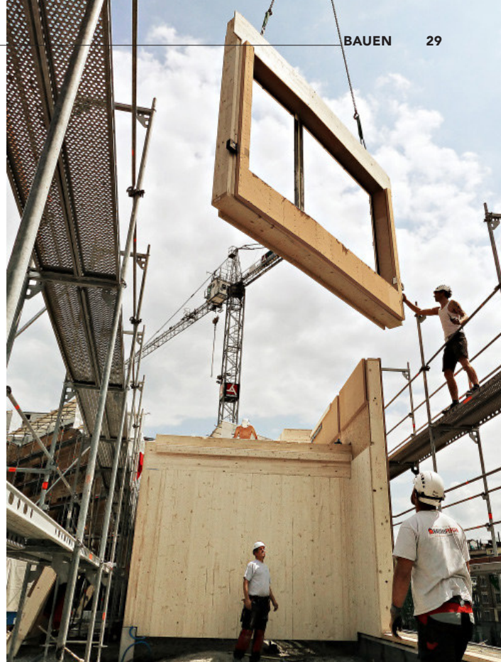
Die Anlieferung für die Montage der Holzelemente für die Aussenwand musste just in time erfolgen.
