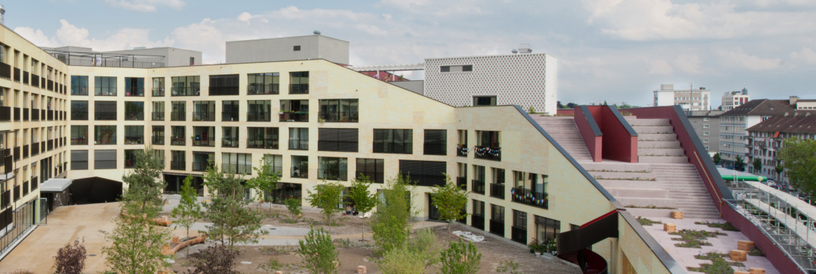
Die 2014 fertiggestellte Überbauung Kalkbreite ist ein spannendes Grossprojekt, das verschiedene Lebensbereiche mit einem hohen Grad an Vernetzung, Flexibilität und Modularität vereint.
