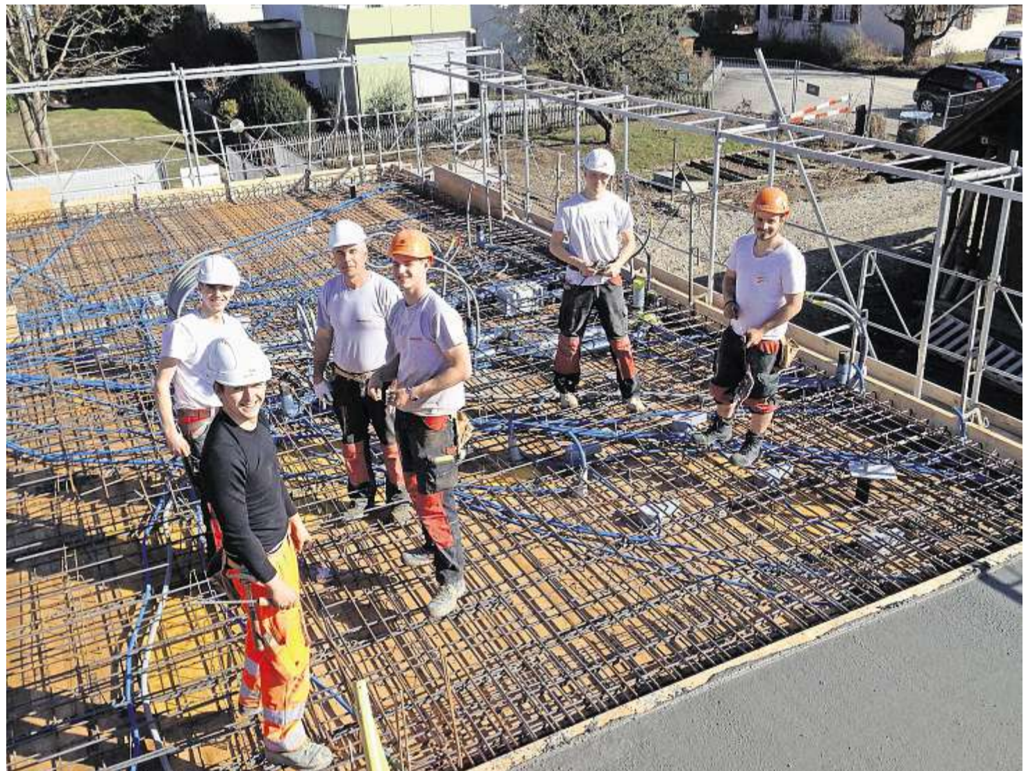
Teamarbeit auf der Lehrlingsbaustelle: Nico Schiess (vorne links) mit Praktikant Marcello (dahinter), Kranführer Agim Berisha, Nino Gasser, Michael Hunziker und Lucas Ayala. Auf dem Bild fehlen die Lehrlinge Rui Da Silva und Hüseyin Göçer.
